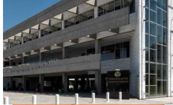
Diyarbakır Yenışehir Belediyesi Hizmet Binası
